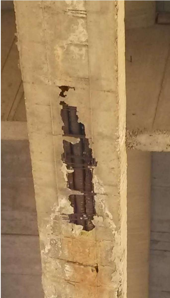
Altro errore di costruzione frequente nei primi ponti precompressi con cavi scorrevoli era la mancanza di spazio tra le guaine per far passare il calcestruzzo, aggravato dalla insufficiente vibrazione dello stesso.
