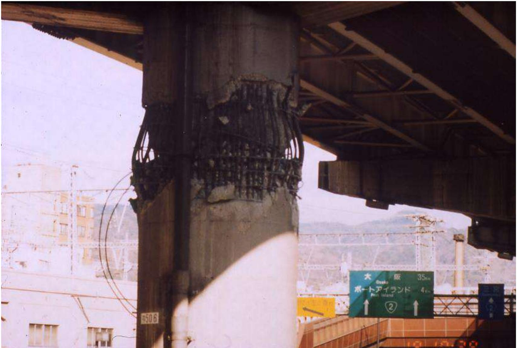
Nei primi cavi di precompressione l'iniezione delle guaine era spesso mal fatta con conseguente corrosione dell'acciaio, fino alla rottura del cavo stesso.
